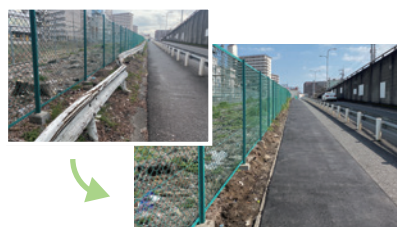
三国ヶ丘駅周辺の歩道の改修
