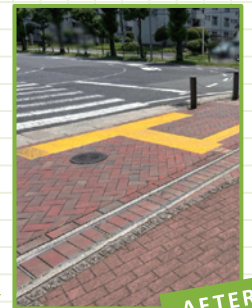
イオンモール堺北花田周辺の点字ブロックの新規設置
