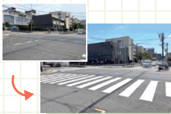
長尾中学校前 横断歩道の改修
