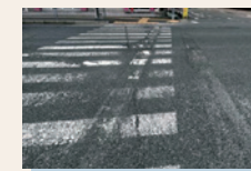
蔵前町交差点横断歩道の改修
